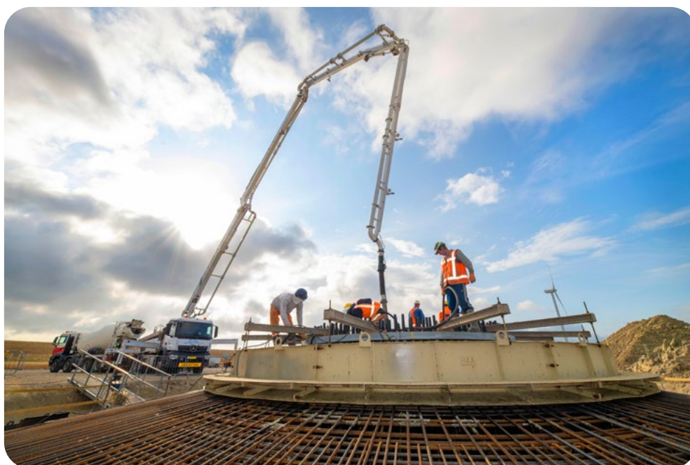
In 2023 zijn de funderingen voor de nieuwe windturbines van windpark Oostzeedijk gestort.
