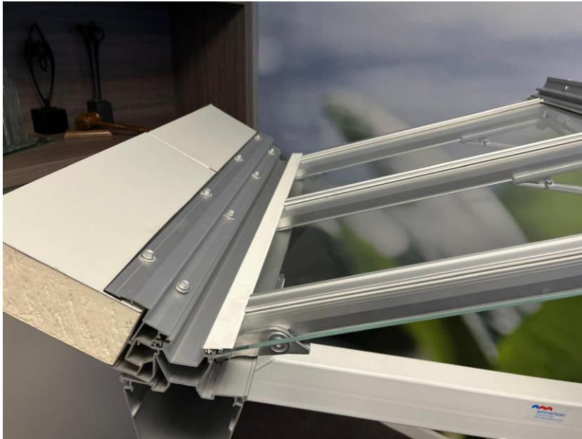
FIGUUR 21 KASDAK MET GEÏNTEGREERDE GOOT
