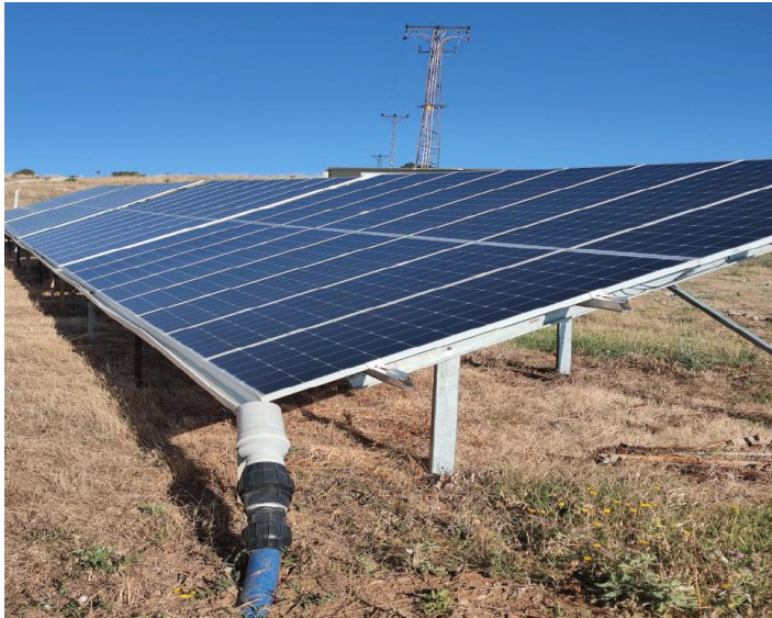
FIGUUR 23 TRADITIONEEL PV SYSTEEM MET PVC GOTEN IN ÇORUM TURKIJE
