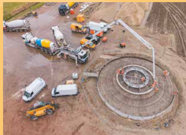
Een fundering voor een windturbine wordt gestort.
